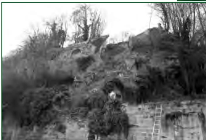
**déblayer les débris, abattre le mur** restant qui est fragilisé, **écrêter le talus**, vider le piège à cailloux et afin de prévenir tout nouvel incident, **installer un grillage de sécurité** de 6 m tendu sur la balme, empêchant la chute de rochers.
