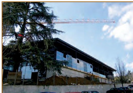
travaux cité scolaire parc Chabrières - mars 2008
