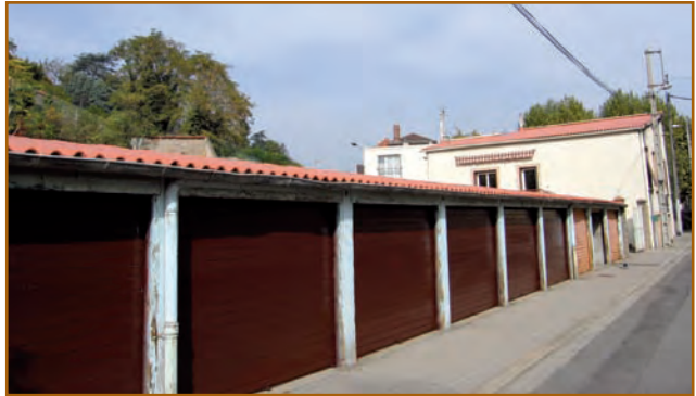
traitement pour les toitures au Confluent et peinture des garages
