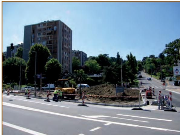
travaux carrefour de Gaulle/Bastéro par le Grand Lyon - été 2008
