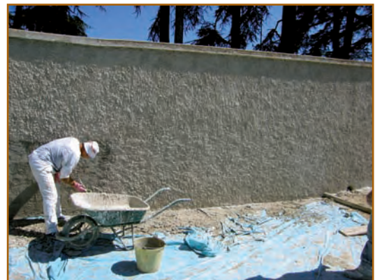
réfection du mur du cimetière vers le carré des musulmans
